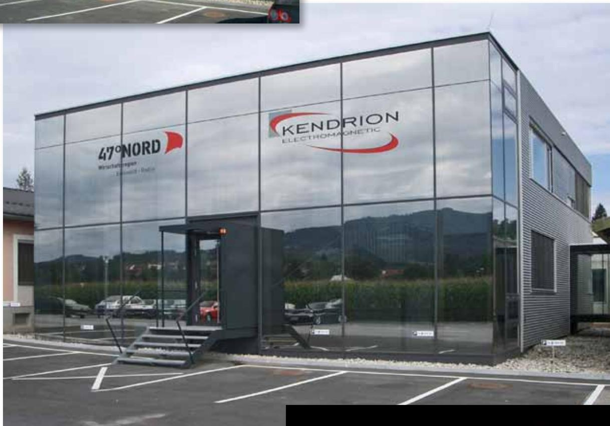
Diese technischen Gegebenheiten lassen daher die Montage einer Innenfolie nur bedingt zu. Der Einsatz einer Außenfolie der Serie GHP Primus hingegen schließt - bei gleichem Schutz vor Sonneneinstrahlung- dieses Risiko aus. Die Folien zeichnen sich zusätzlich durch eine hohe Lebenserwartung und eine besondere Kratzbeständigkeit aus.
